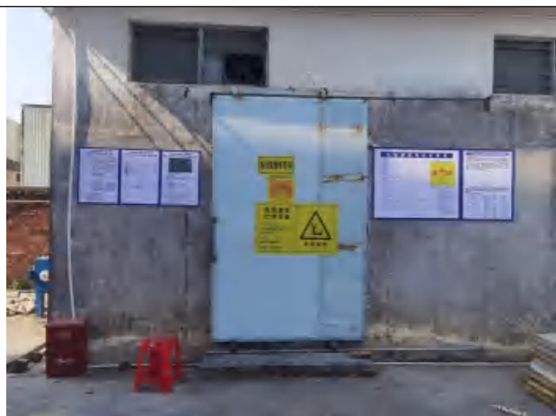
危险废物暂存间
