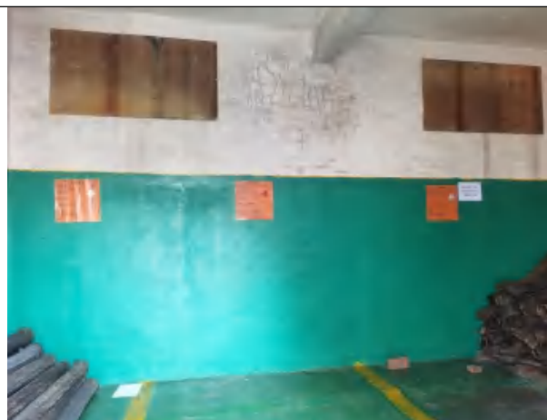
危险废物暂存间内部
