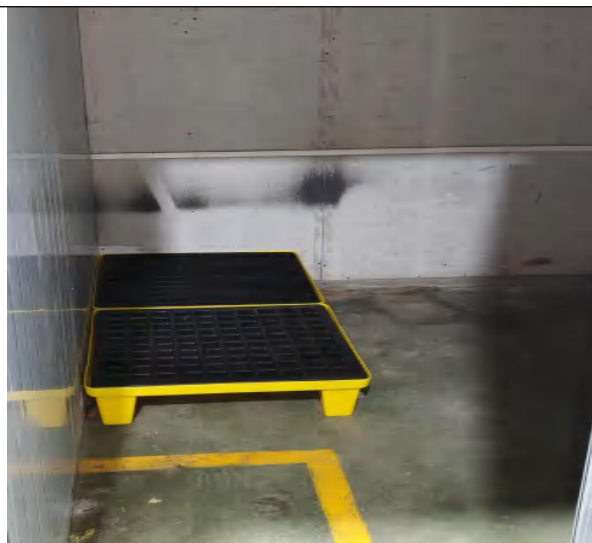
危险废物暂存间
