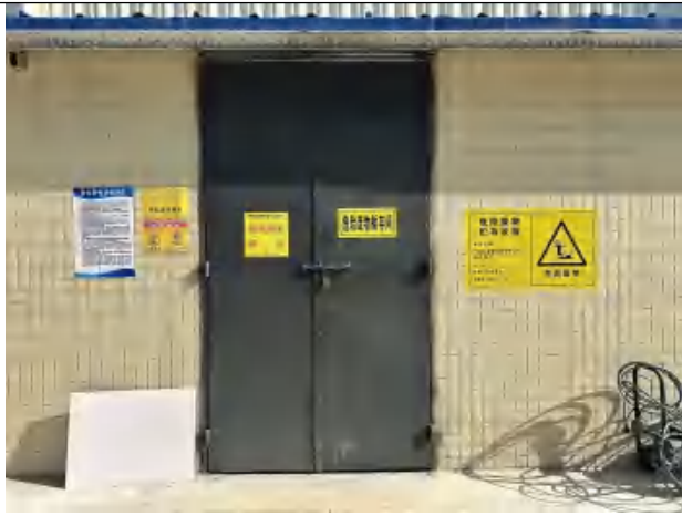
危险废物暂存间外部
