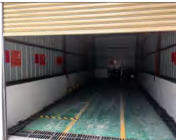
危险废物暂存间
