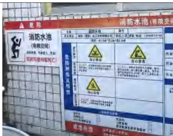
枫树化工厂消防水池
