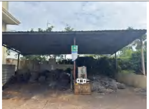
一般固废储存区
