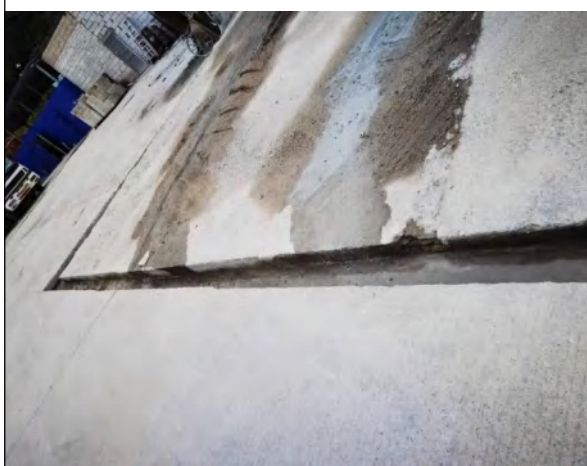
场区废水收集渠道
