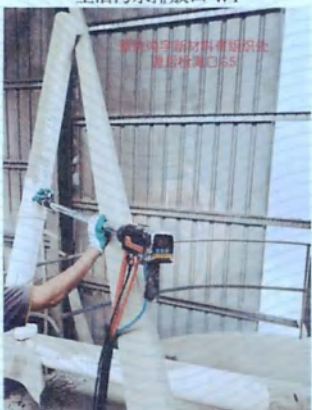
G5 粉料仓废气处理后检测口 (DA001)
