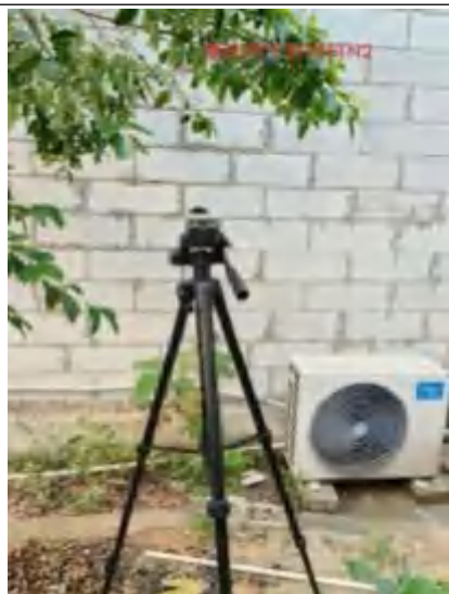
N2 厂界南侧外 1m 处
