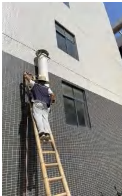
DA004 厨房油烟排放口
