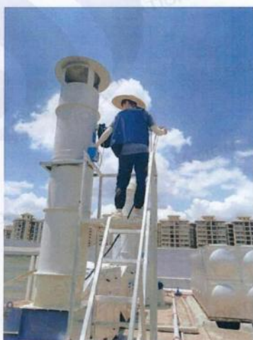
DA001 废气排放口
