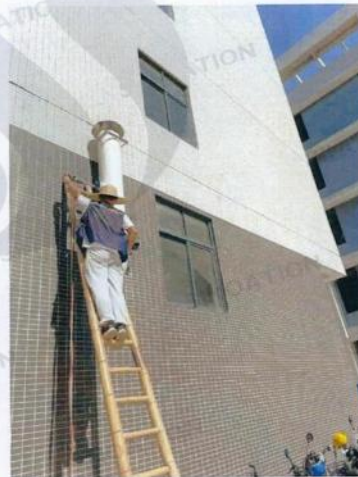
DA004 厨房油烟排放口
