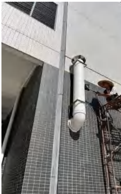
DA003 厨房油烟排放口
