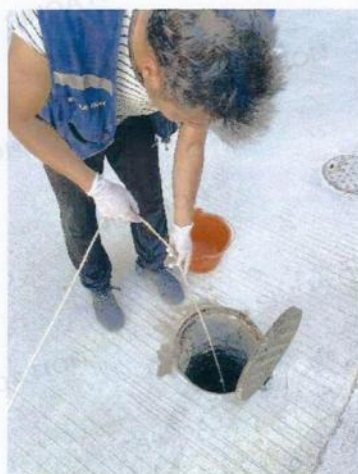
生活污水处理前
