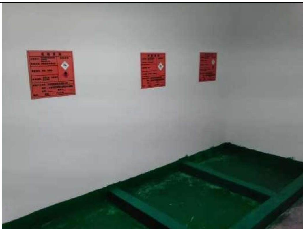
危险废物暂存间内
