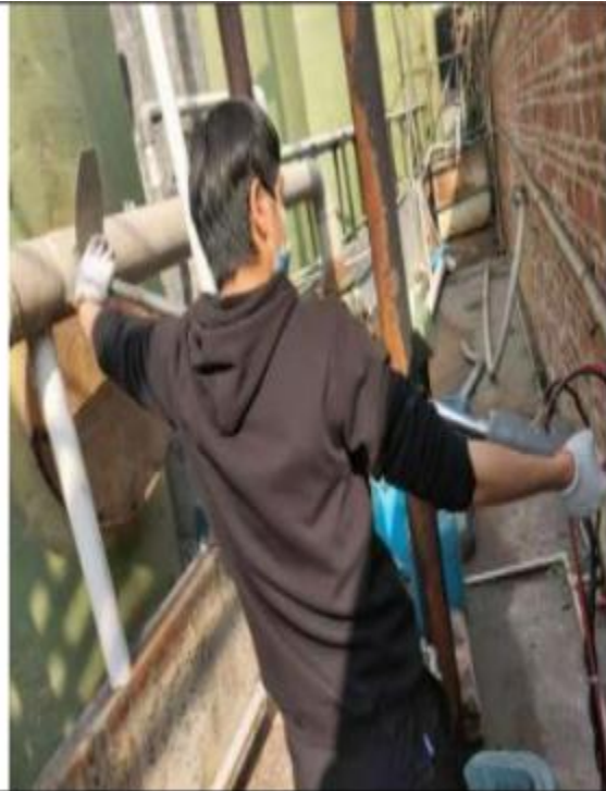
盐酸罐区废气处理前检测口 ○Q3
