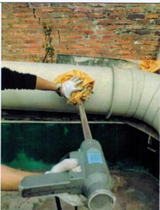
图 9.3 硝酸分装废气处理前检测口 ○Q1
