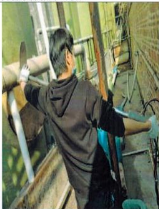
图 9.5 盐酸罐区废气处理前检测口 ○Q3
