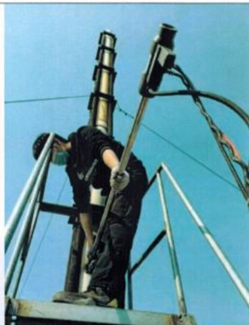
图 9.6 盐酸罐区废气处理后检测口 ○Q4
