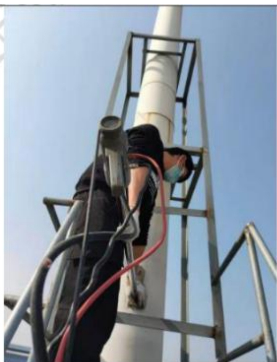
硝酸分装废气处理后检测口 ○Q2
