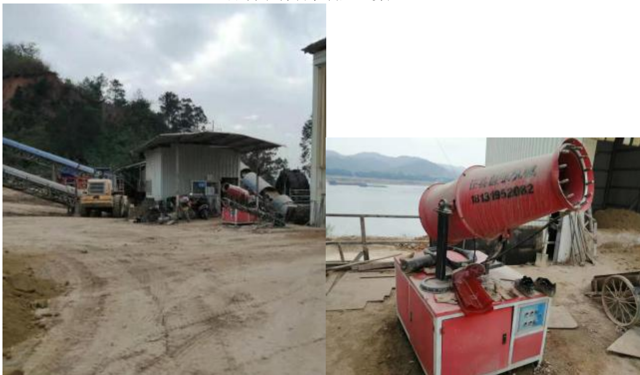
原料堆场洒水装置（雾炮）
